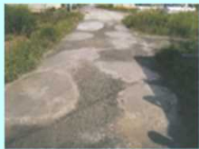
農道の窪みの補修
