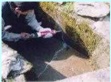
水路のひび割れ補修
