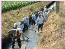
水路の泥上げ
