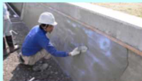
老朽化した水路壁のコーティング
